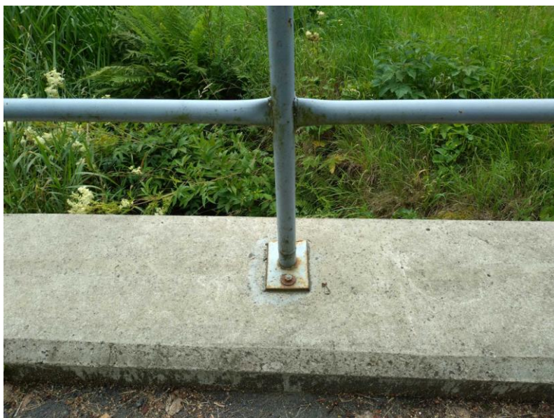
Detail zábradlí s poškozenou PKO.
