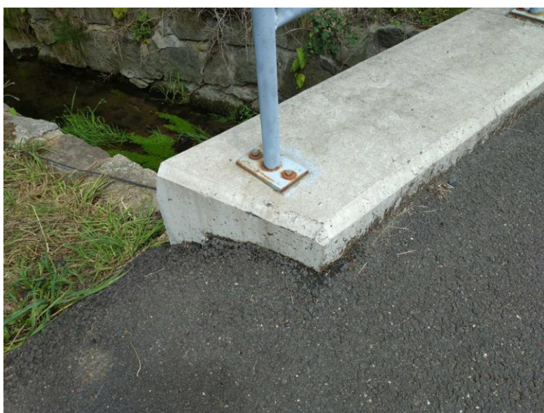
Ukončení římsy bez náběhů, absence těsnící zálivky ve vozovce.
