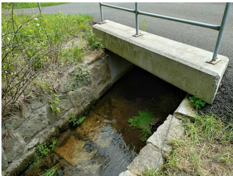
Výtoková římsa a opevněné dno.
